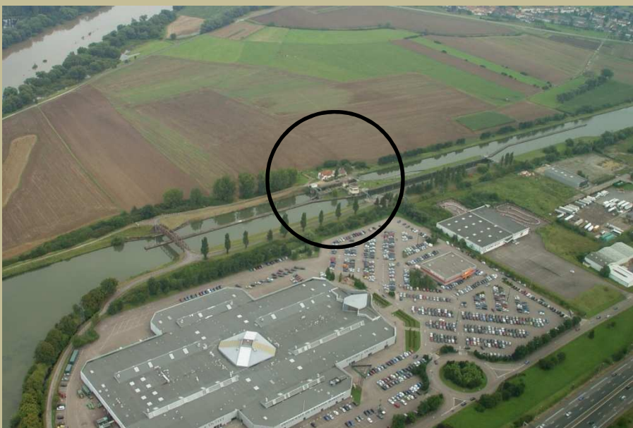
Ecluse de Talange
