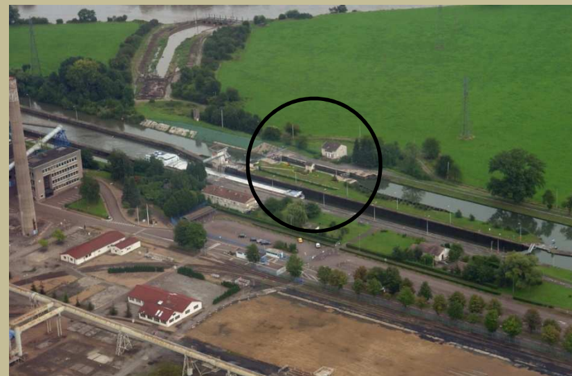
Ecluse de l'Orne - Richemont
