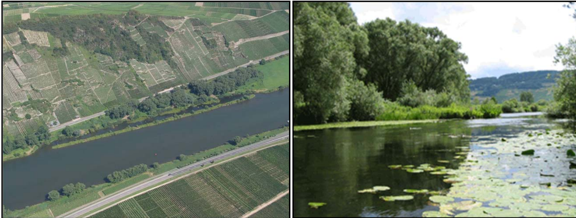
Parallelwerk, Mosel-km 159; Baujahr 1967
