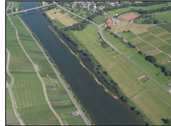
Parallelwerk, Mosel-km 135; Baujahr 1993
