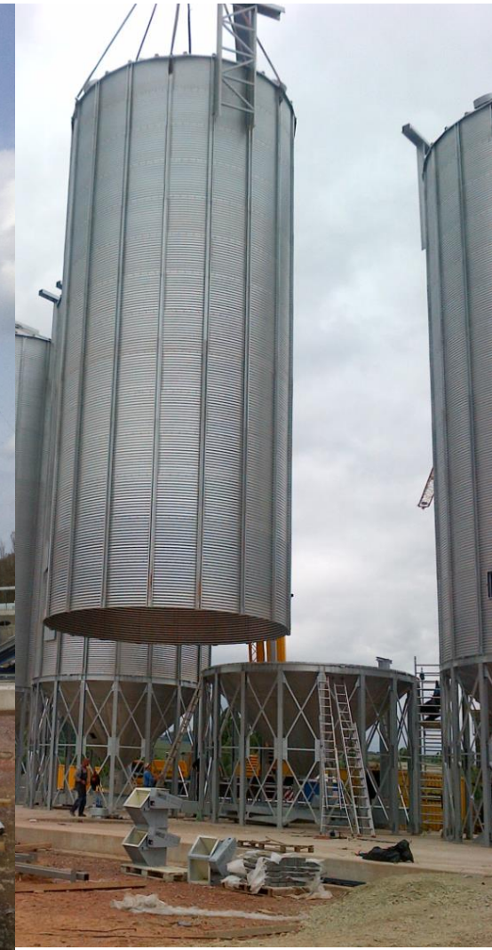
12.06.2013: Kleines Silo wird gehoben.
